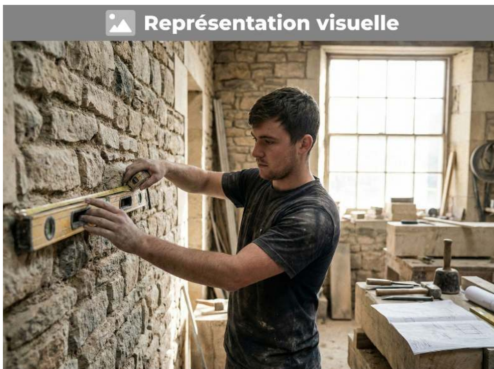
Vérification des cotes avec tolérance de \pm 5 mm pour un parement régulier
